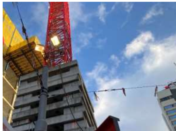
Abbildung 4: Kennzeichnung der Fahrleitungsaufhängung durch rot-weiße Wimpel
